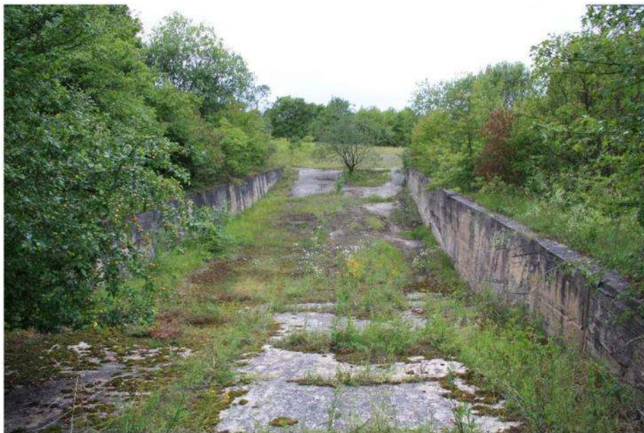
Abb. 3: Ehemalige Panzerwaschanlage auf dem Rödel (NATURSTIFTUNG DAVID 2011).
